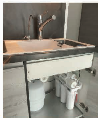
POSE SOUS ÉVIER
